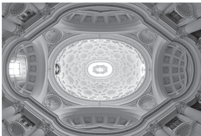
fig. 10.16 Les trois étages de la nef et les déformations des branches de la croix grecque. La coupole repose sur quatre arcs. Deux torsadés et surbaissés. Deux en plein cintre
