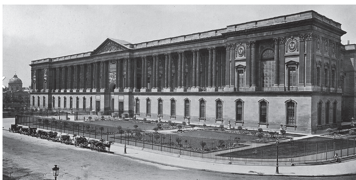
fig. 11.4 Façade orientale et le parvis. L'ordre de la colonnade : de mural à squelettique
