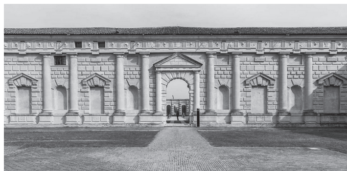
fig. 7.10 La cour. Vestiges d'une villa antique restaurée
