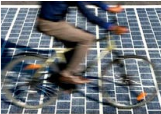
Projet WattWay, revêtement carrossable photovoltaïque, COLAS Industries
