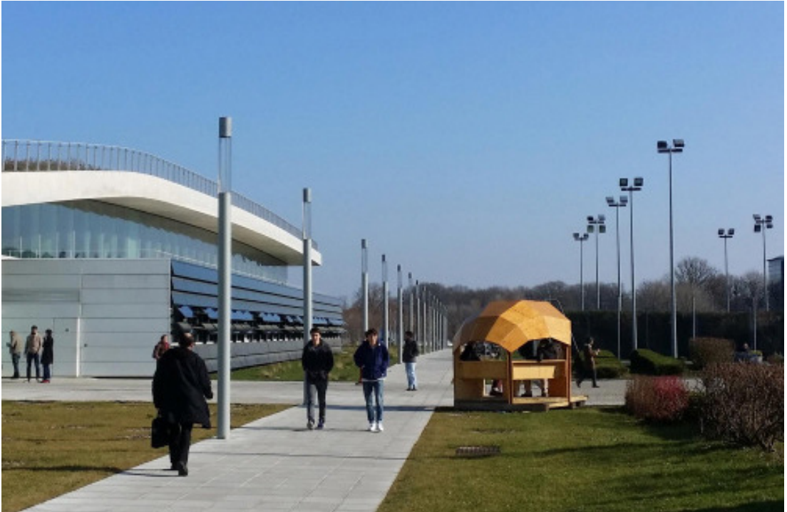
Parvis de l'École Nationale des Ponts et Chaussées et de l'IFSTTAR, zone centrale et fédératrice du campus : une vie urbaine essentiellement diurne.
