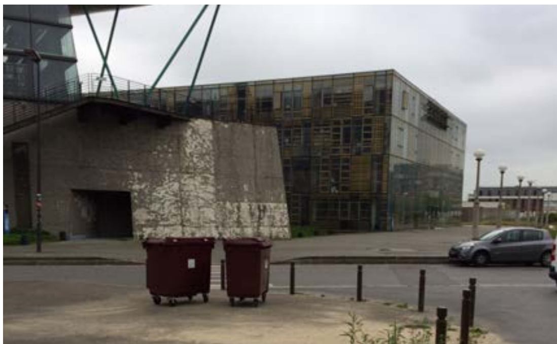
Des aménagements extérieurs peu soignés.
