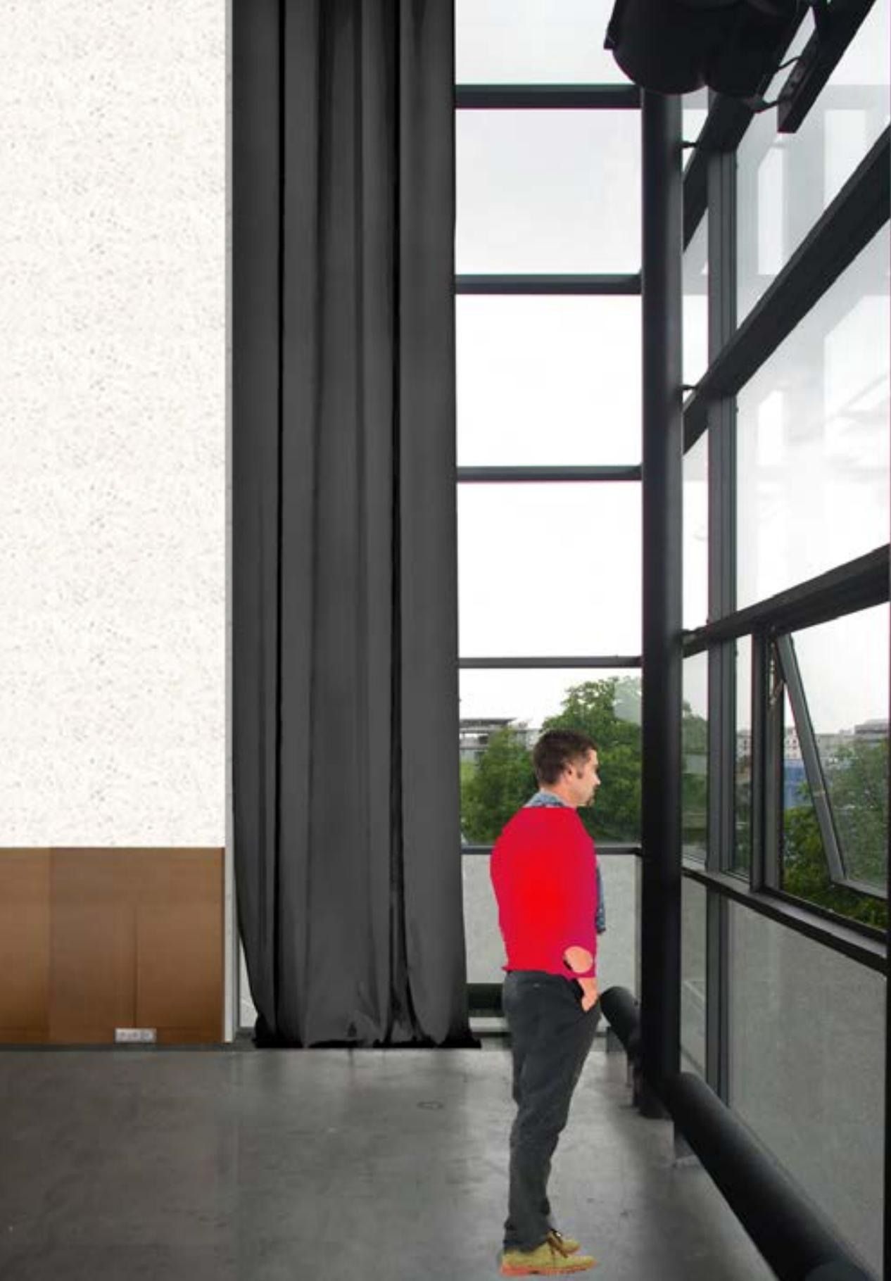
Nous proposons donc une solution intermédiaire qui viserait à diminuer au maximum les déperditions vers l'extérieur des chauffages, situés le long du vitrage. En conservant la façade existante, nous conseillons d'installer sur toute la partie basse de la façade (jusqu'à la première menuiserie située à environ 120 cm du sol) un matériau isolant et translucide, par exemple le produit Kapipane de la marque Okalux ou un équivalent (voir image de la page suivante).
